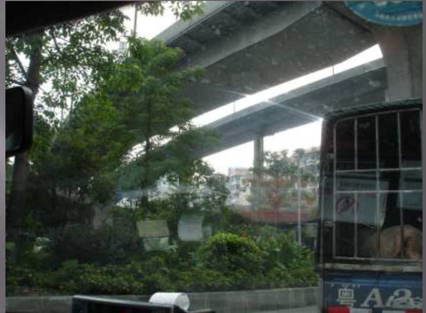
2008 Guangzhou, 2 ème niveau de rue
